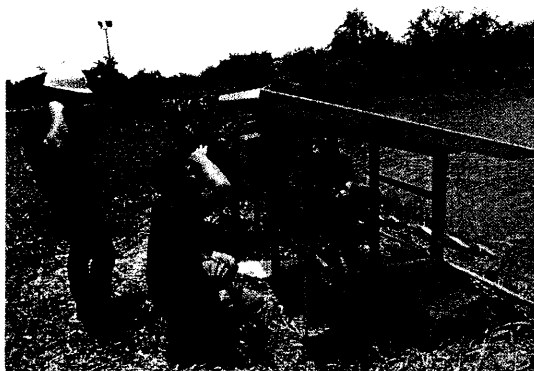
ภาพ การติดตั้งแผงเซลล์แสงอาทิตย์ร่วมกับเครื่องเติมอากาศบริเวณบ่อของเกษตรกรที่เพาะเลี้ยงกุ้ง
